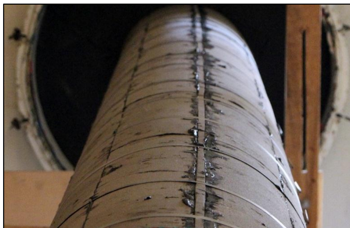
Рисунок 7 – Монтаж скорлуп и сегментов
