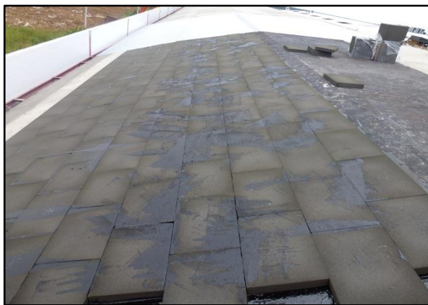
Рисунок 4 – Раскладка плит на горизонтальной поверхности
