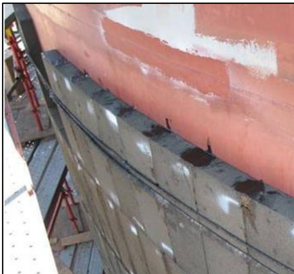
Рисунок 3 – Монтаж теплоизоляционных плит и защитного покрытия
